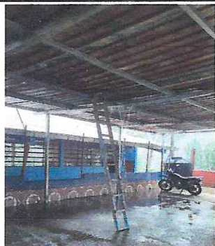
Foto 5: Practicamente en toda la parte del techo es empoza el agua debido a lo dañado de cada una de las laminas.
