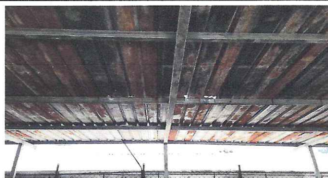
Foto 6: varias de las costanera que le sirven de soporte ya se encuentran a punto de quebrarse debido al peso del agua que se acumula en la parte de arriba.
